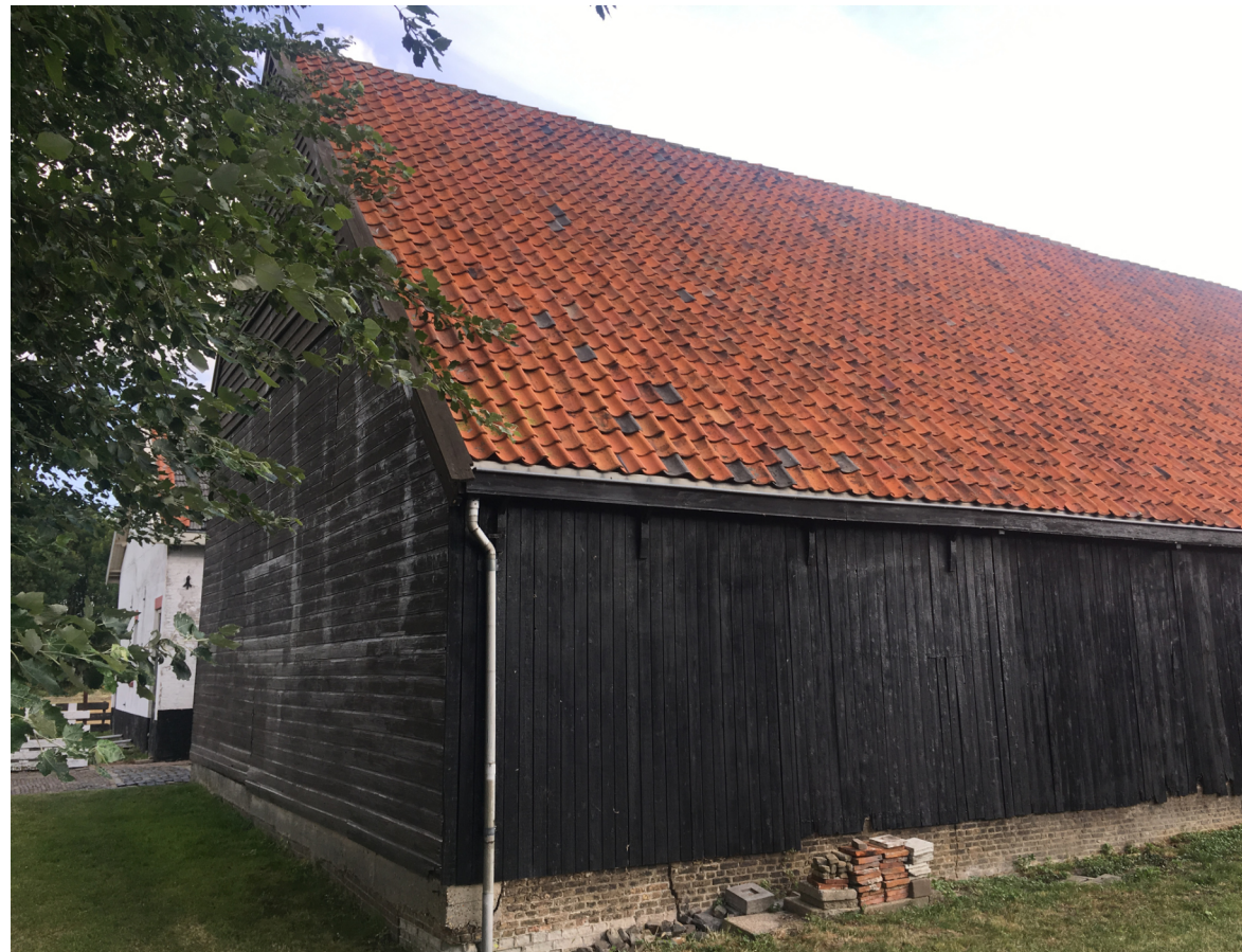
Lattengevel & constructie hooischuur
